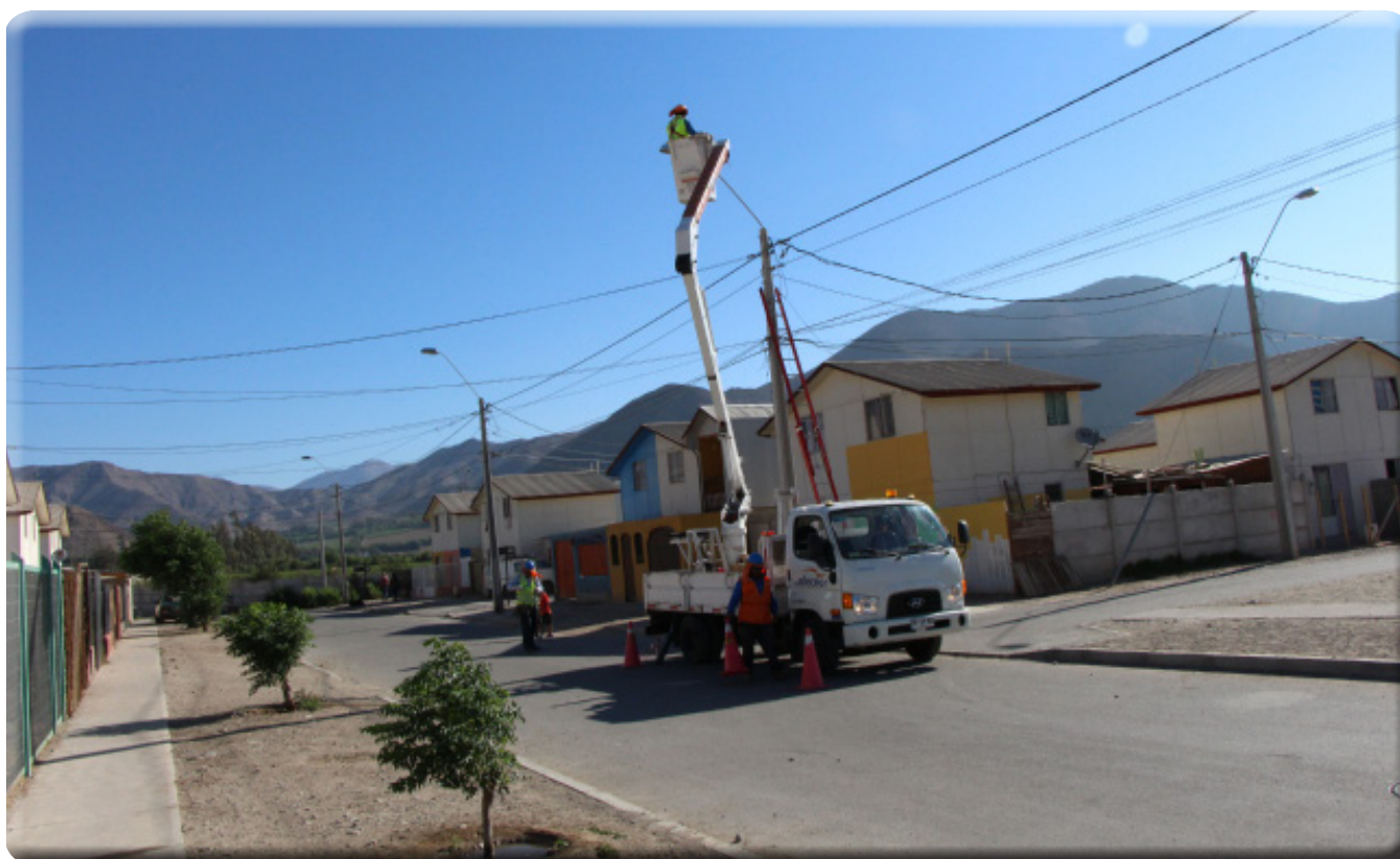
Recambio de las luminarias del alumbrado público
