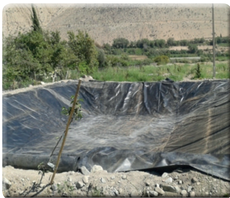
Impermeabilización de estanque con geomembrana, proyecto financiado a través de Proyectos de obras menores de riego.
