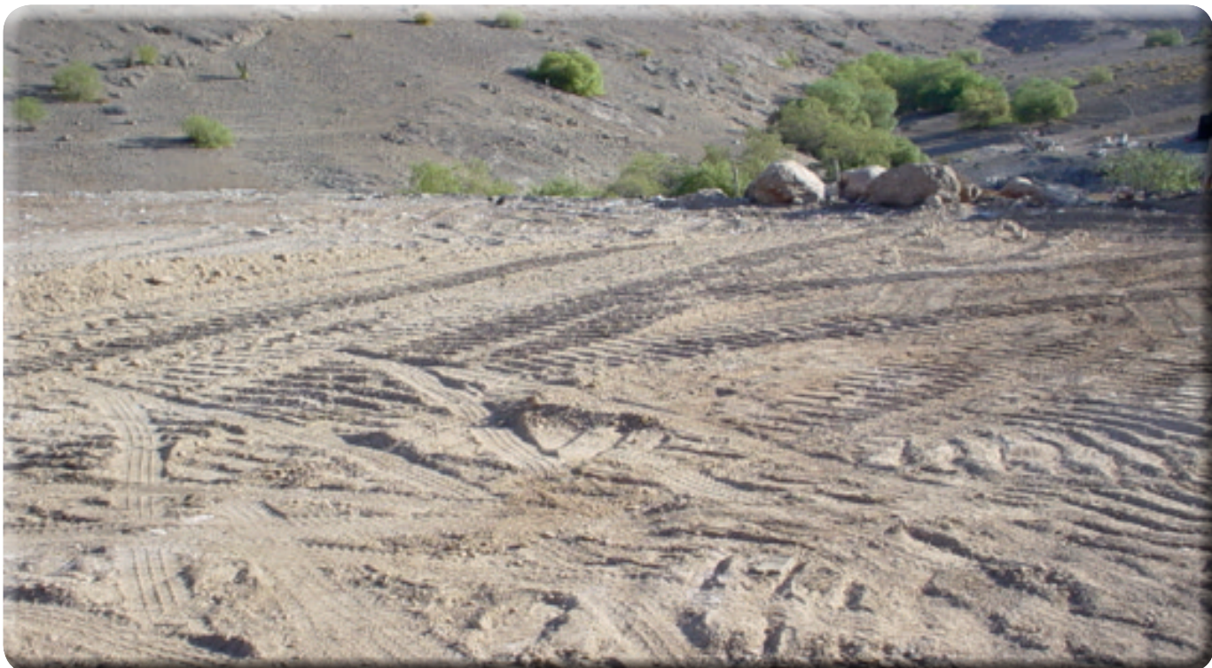
Cobertura final de los residuos
