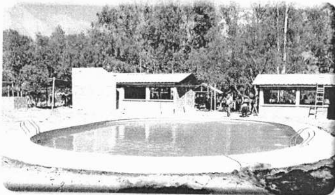
EN EJECUCION Construcción Piscinas de 70, 100 y 150 m 2
